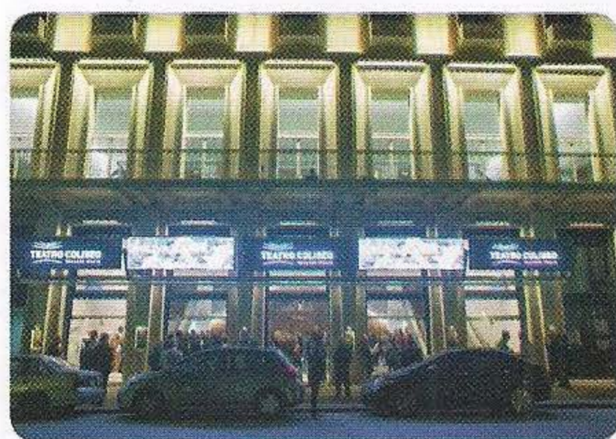
La nueva fachada con LEDs
